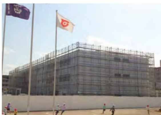
▶建設が進む戸田第一小学校の新仮設校舎
